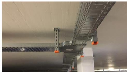
Wo so viele Superlative warten, ist OBO nicht weit: Auch OBO-Produkte aus dem Bereich der Industrieinstallation sind Teil des Projektes PANDION DOXX. Steigeleitern und RKSM-Kabelrinnen werden im Bereich der Tiefgarage und Geschoss übergreifend installiert. Mit einer speziellen Fluchtweginstallation mit 85mm Holm Höhe in der Einfahrt der Tiefgarage begeistert OBO auch mit einer Sonderlösung im Rahmen dieses Projektes.
